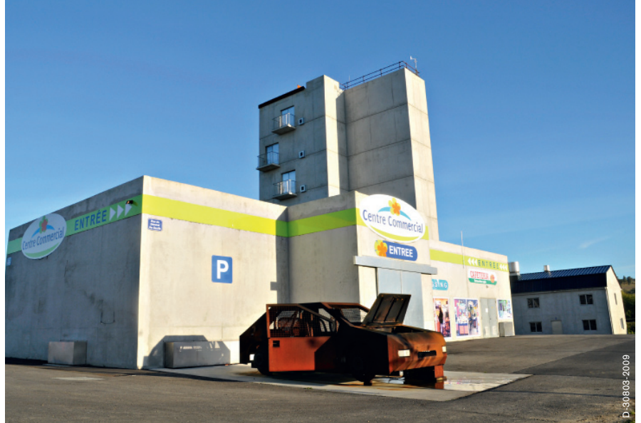
Kein Kaufhaus in der Banlieue, sondern ein Übungsobjekt in Vire.
